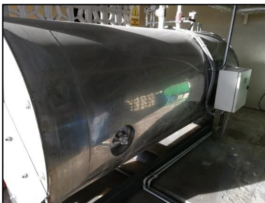
Figura 2.2 Caldera de vapor de tipo piro tubular
