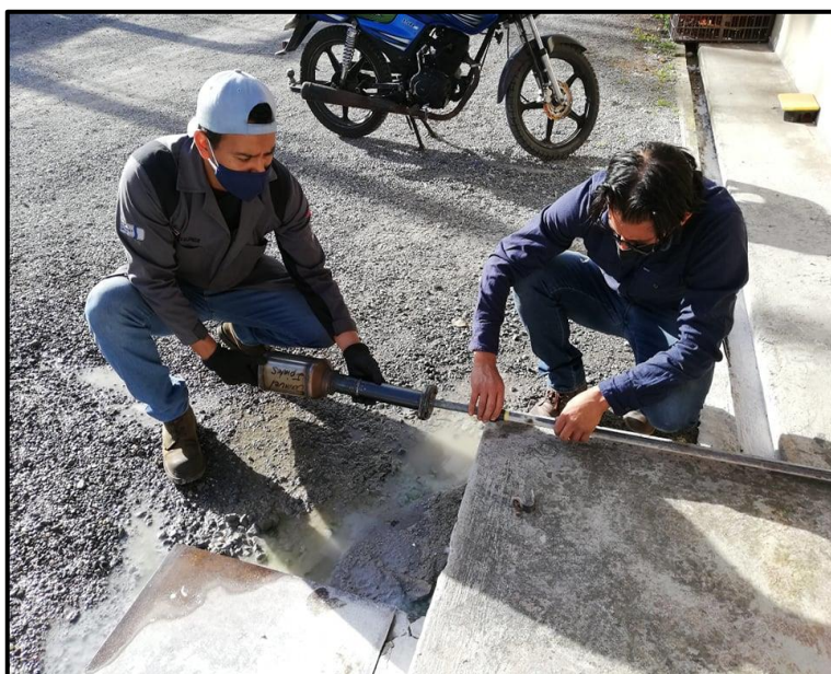
Figura AVI.2. Acoplamiento del catalizador con la válvula de purga de la caldera
