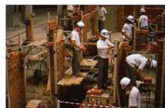
CASA EN CONSTRUCCIÓN
