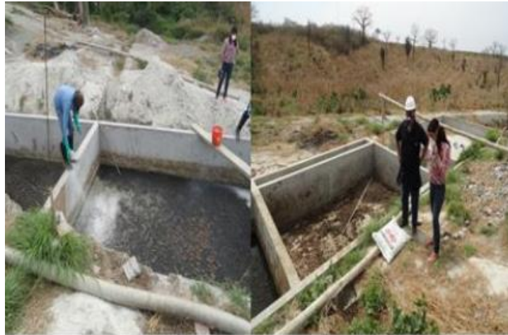
Figura 16. Aplicación de cal en los lodos residuales
