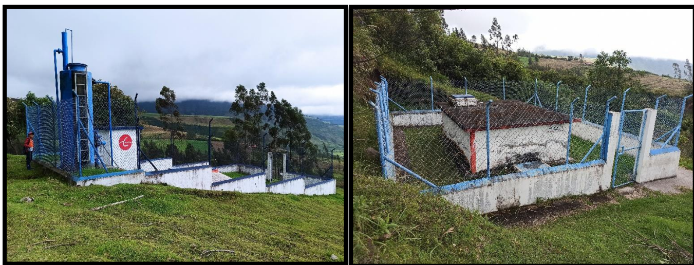
Figura 60: Infraestructura del sistema de agua potable
