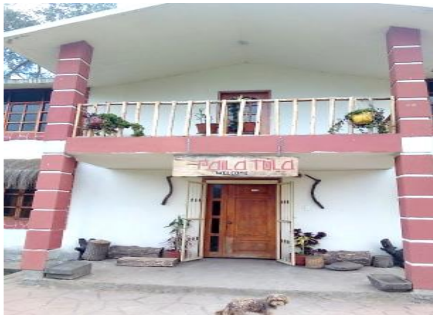
Figura 52. Infraestructura del Emprendimiento Paila Tola
