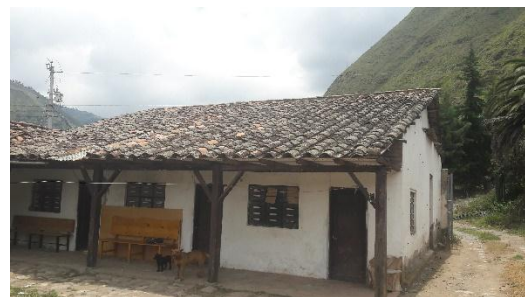
Figura 83. Infraestructura lateral actual. 2020
