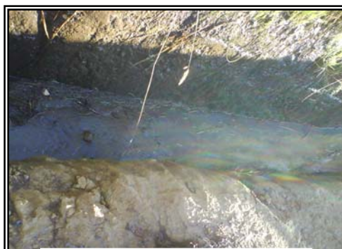
Descarga ubicada en el filo del puente nuevo
