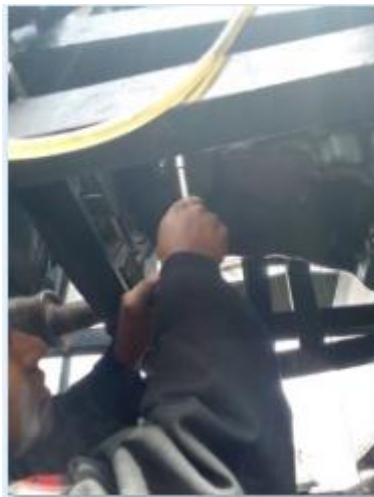
Figura 52 Desmontaje de bancadas
