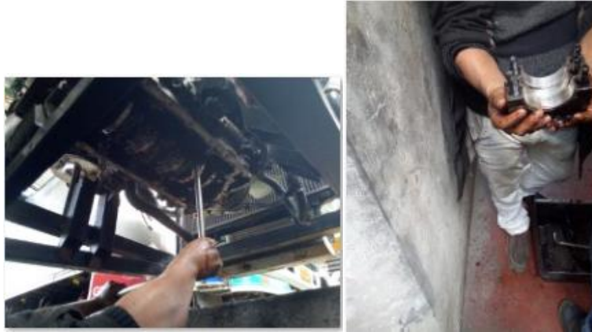
Figura 55 a) Extracción de los pernos sujetadores b) Bancadas extraídas
