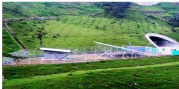
Fig. 9 Esta planta de energía solar suministra iluminación autónoma al túnel Santa Rosa vía Dosquebradas
