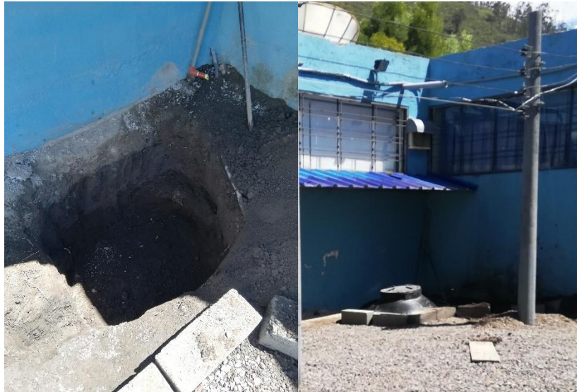
Figura 22 Excavación y ubicación del tanque reservorio
