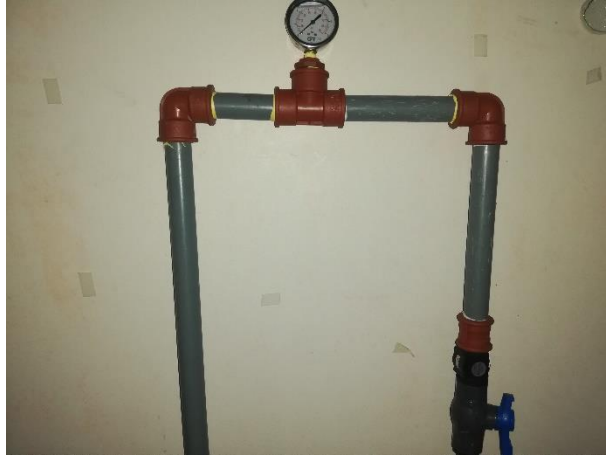
Figura 25 Manómetro y Sensor de Caudal
