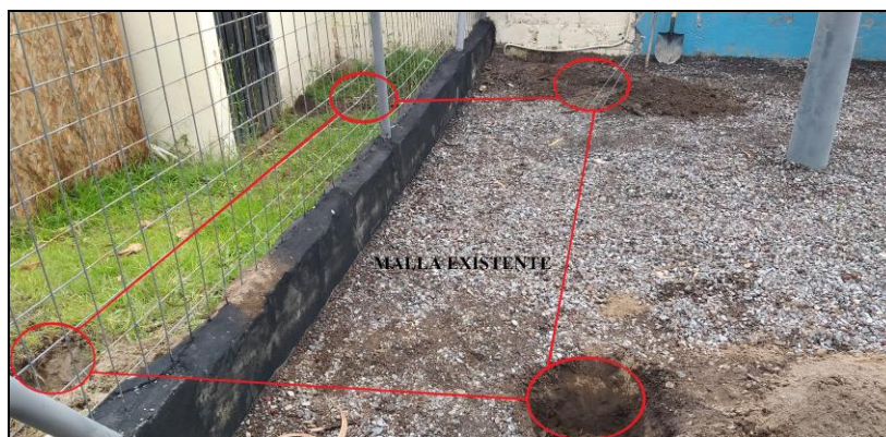
Fig. 17. Malla existente Fuente: (Autor, 2021)
