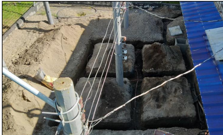
Fig. 45. Tendido total del conductor de cobre. Fuente: (Autor, 2021)
