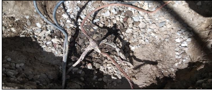
Fig. 55. Conexión de las dos mallas. Fuente: (Autor, 2021)
