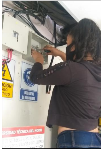
Fig. 60. Conexión del sistema de puesta a tierra reconfigurada al tablero de distribución. Fuente: (Autor, 2021)
