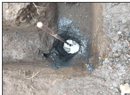
Fig. 43. Instalación de la varilla copperweld. Fuente: (Autor, 2021)
