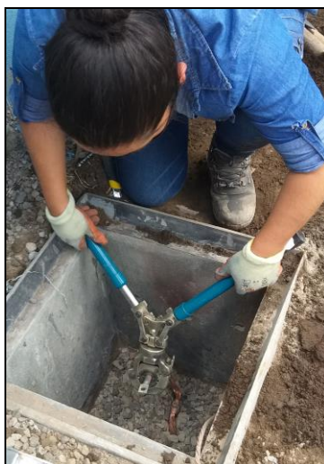
Fig. 58. Machinado de los terminales tipo ojo a los conductores de tierra. Fuente: (Autor, 2021)
