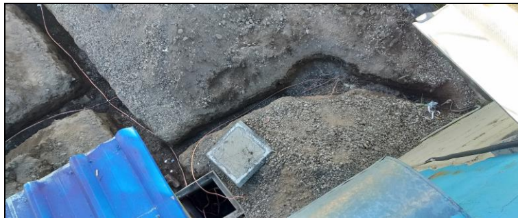
Fig. 54. Excavación de zanja para conectar la malla existente. Fuente: (Autor, 2021)
