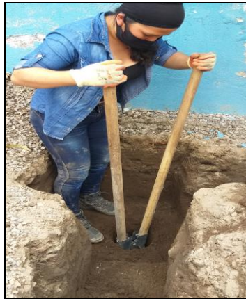
Fig. 42. Excavación de hueco para las varillas copperweld. Fuente: (Autor, 2021)
