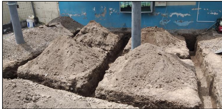
Fig. 40. Excavación de la zanja. Fuente: (Autor, 2021)
