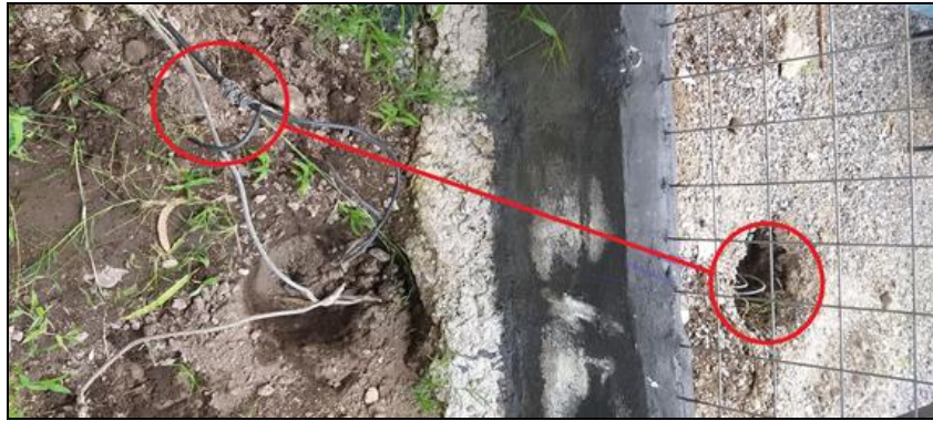
Fig. 16. Puesta tierra de la Bobina de Tesla. Fuente: (Autor, 2021)
