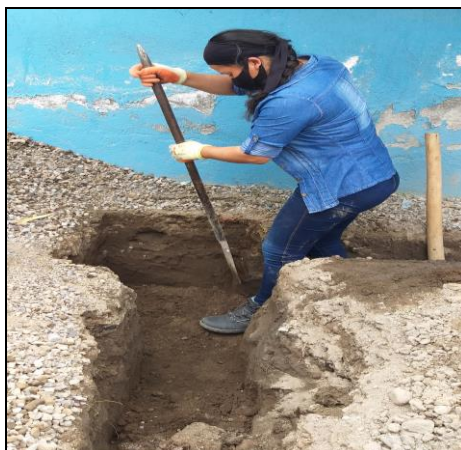
Fig. 41. Excavación del hueco para el pozo. Fuente: (Autor, 2021)
