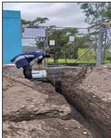
Fig. 47. Colocación del compuesto químico GEM Fuente: (Autor, 2021)
