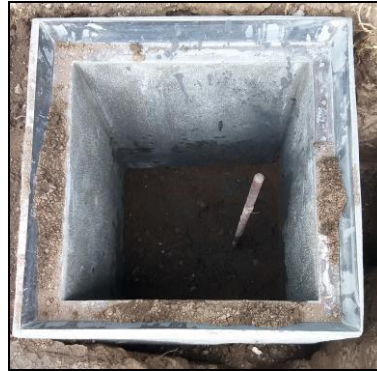
Fig. 48. Pozo de revisión. Fuente: (Autor, 2021)
