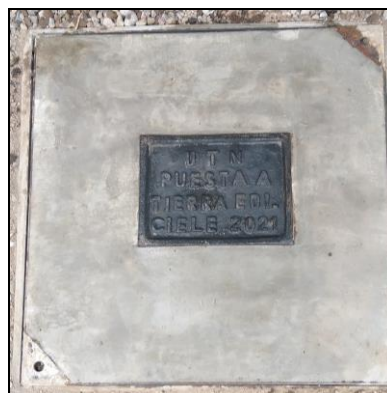
Fig. 49. Tapa del pozo de revisión. Fuente: (Autor, 2021)
