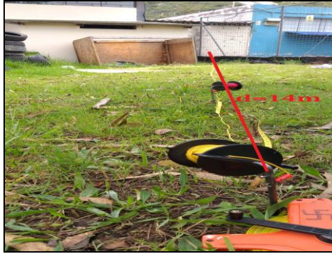
Fig. 30. Ubicación para la medición de la resistencia de puesta a tierra del sistema de generación. Fuente: (Autor, 2021)
