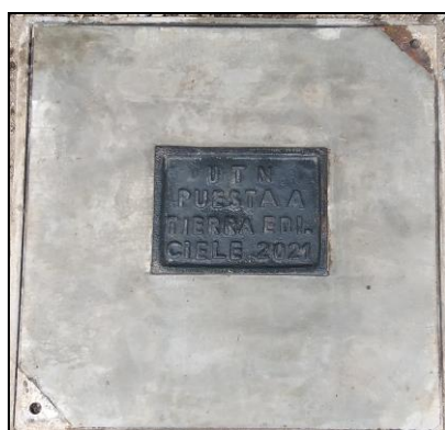
Fig. 65. Tapa del pozo de revisión Fuente: (Autor, 2021)
