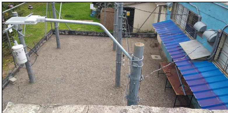
Fig. 63. Instalación del ripio en el área de la nueva malla. Fuente: (Autor, 2021)
