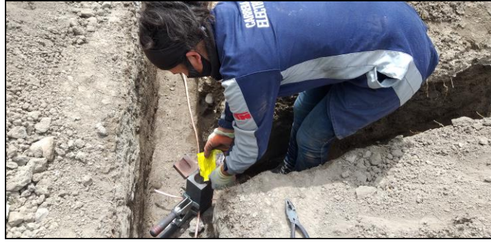
Fig. 52. Proceso de soldadura exotérmica.
