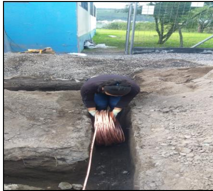
Fig. 44. Tendido del conductor de cobre. Fuente: (Autor, 2021)
