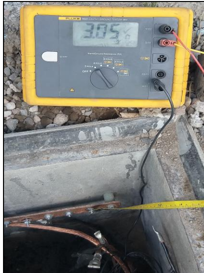
Fig. 67. Conexión del equipo de medición con la tierra de la nueva malla. Fuente: (Autor, 2021)
