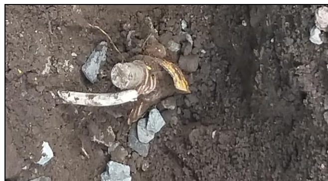
Fig. 24. Conexión del electrodo Fuente: (Autor, 2021)
