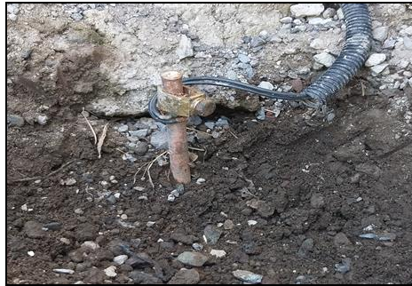
Fig. 29. Electrodo en el pozo Fuente: (Autor, 2021)
