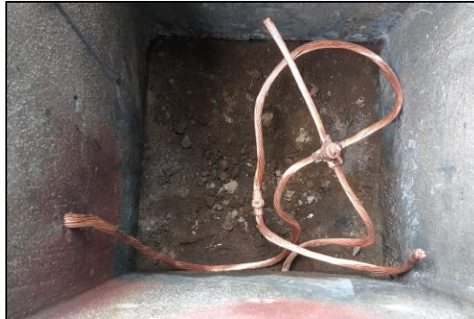
Fig. 50. Soldadura exotérmica cable - varilla y cable – cable. Fuente: (Autor, 2021)
