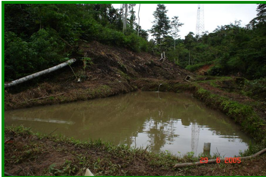
Foto 5. Piscina 1, Implementación del Tratamiento 1
