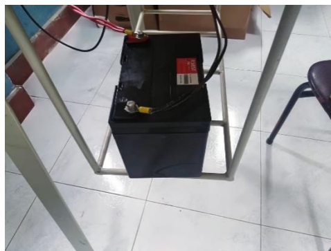
Fig. 43 Montaje e instalación de la batería de 35ah 12V Fuente: Autor
