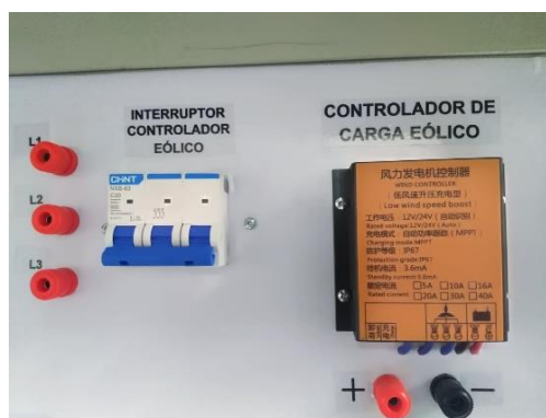
Fig. 41 Montaje del breaker trifásico y controlador eólico Fuente: Autor
