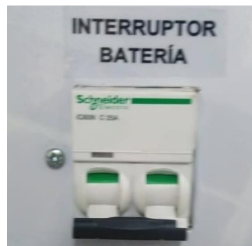
Fig. 42 Instalación del interruptor de protección de la batería Fuente: Autor
