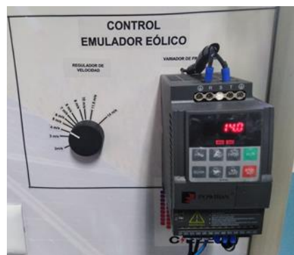
Fig. 51 Montaje del variador de frecuencia de 1 Hp Fuente: Autor
