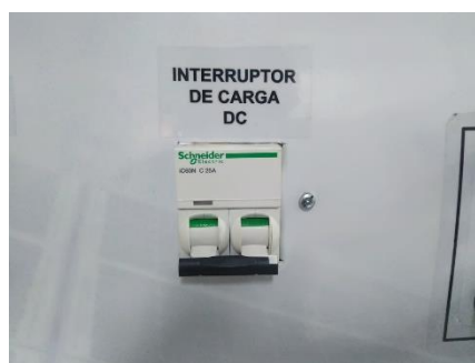
Fig. 45 Montaje e instalación del interruptor de protección de las cargas DC Fuente: Autor
