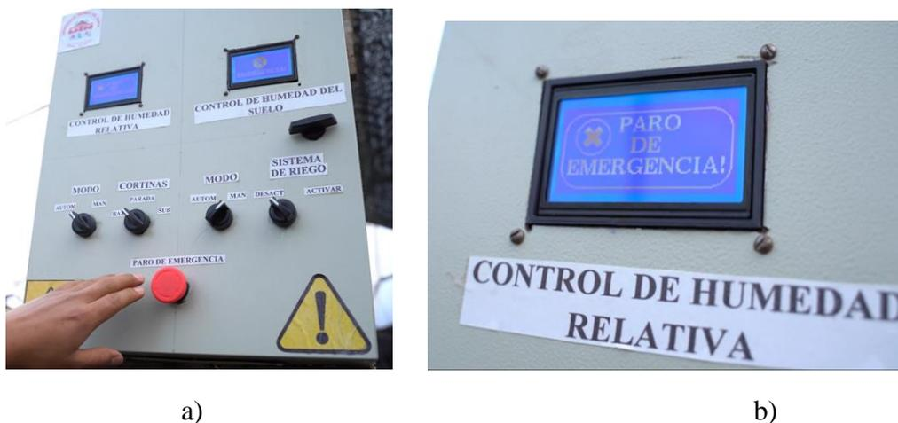
*Nota.* a) Activación del paro de emergencia por parte del usuario, b) disparo de pantalla de emergencia y detención de actuadores.
