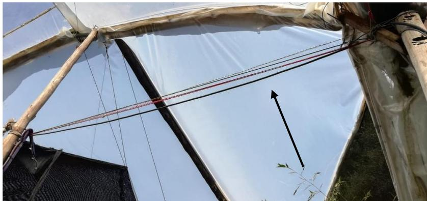
Figura 38. Cables para la red principal 220V y secundaria 110V
