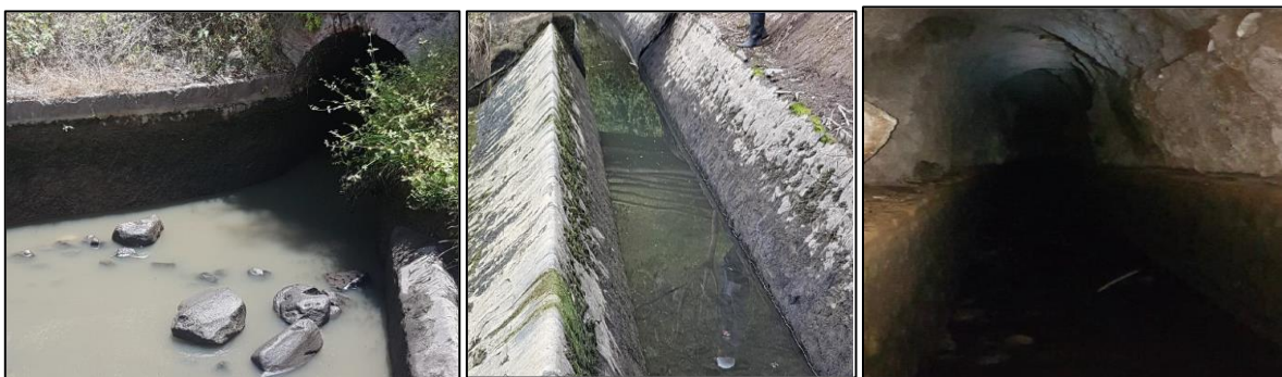
Fig. 8 Canales y túneles de conducción de agua Fuente: Memoria técnica SERMAA EP, (s.f)
