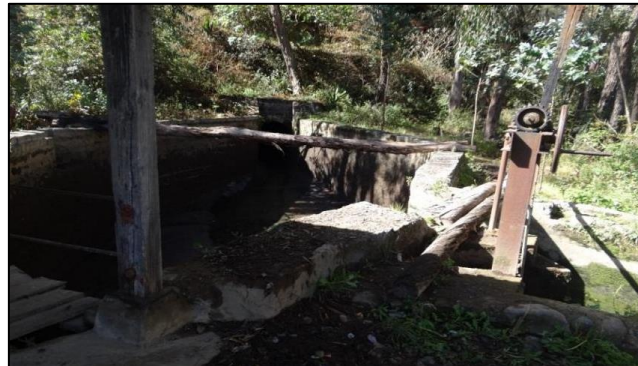
Fig. 22 Cámara de carga Fuente: Memoria técnica SERMAA EP, (s.f)
