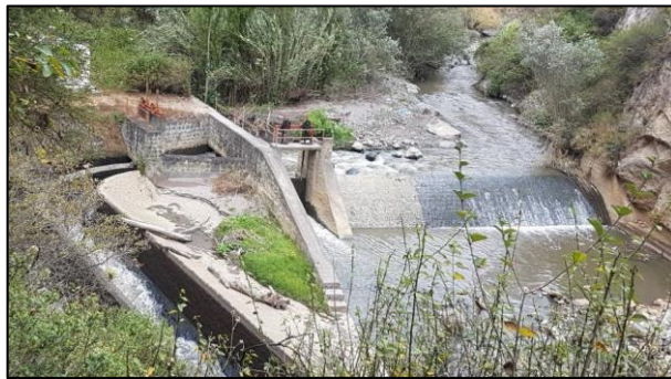
Fig. 5 Bocatoma Fuente: Memoria técnica SERMAA EP, (s.f)
