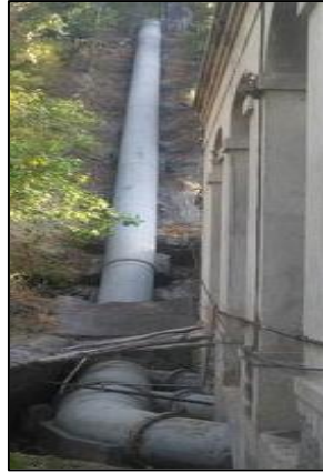
Fig. 23 Tubería de presión Fuente: Memoria técnica SERMAA EP, (s.f)
