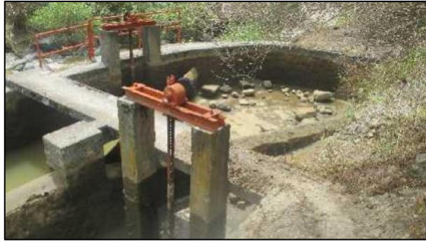
Fig. 7 Desarenador Fuente: Memoria técnica SERMAA EP, (s.f)
