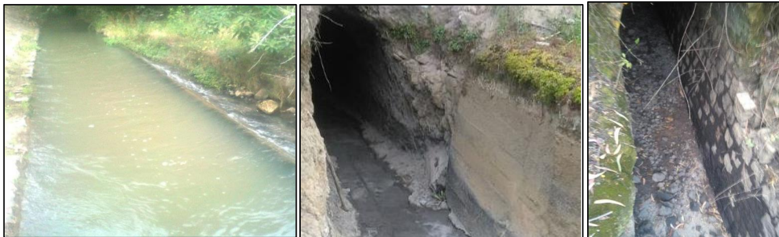
Fig. 21 Canales y túneles de conducción de agua Fuente: Memoria técnica SERMAA EP, (s.f)
