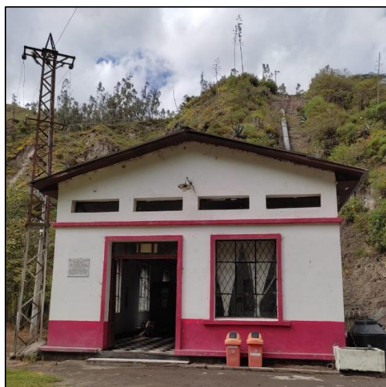
Fig. 11 Casa de máquinas Fuente: Propia del autor, 2021
