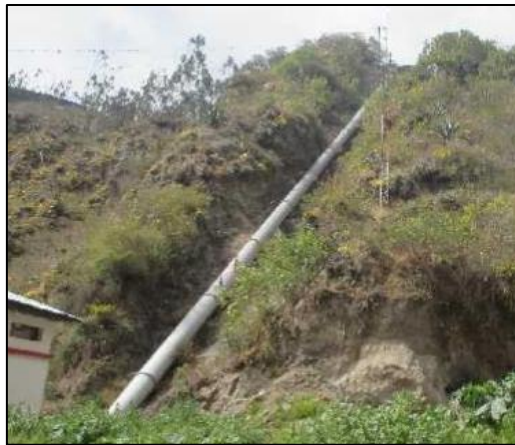
Fig. 10 Tubería de presión Fuente: Memoria técnica SERMAA EP, (s.f)
