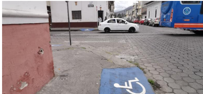
Figura 54. Cruce de calle entre la Vicente Rocafuerte y Eusebio Borrero
