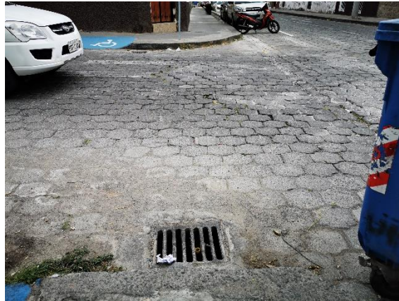
Figura 41. Cruce de calle entre la José Joaquín Olmedo y Eusebio Borrero
