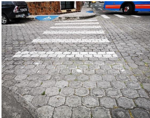
Figura 73. Cruce de calle entre la Pedro Vicente Maldonado y Eusebio Borrero
