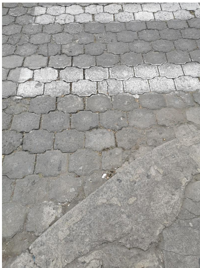
Figura 8. Cruce de calle entre la Sánchez y Cifuentes y Eusebio Borrero
