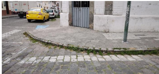
Figura 34. Cruce de calle entre la José Joaquín Olmedo y Eusebio Borrero
