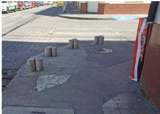
Figura 21. Cruce de calle entre la José Joaquín Olmedo y Eusebio Borrero
