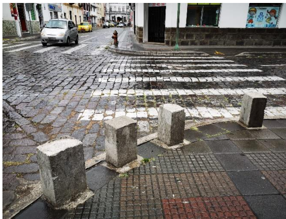
Figura 132. Cruce de calle entre la Miguel Oviedo y Sánchez y Cifuentes
