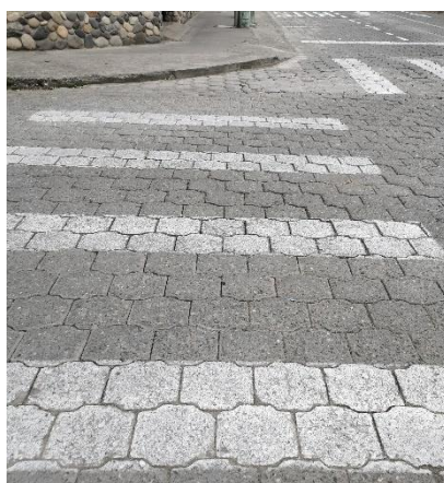
Figura 67. Cruce de calle entre la Pedro Vicente Maldonado y Eusebio Borrero
