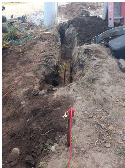
Figura G 32: Obtención de datos en campo proyecto eléctrico
