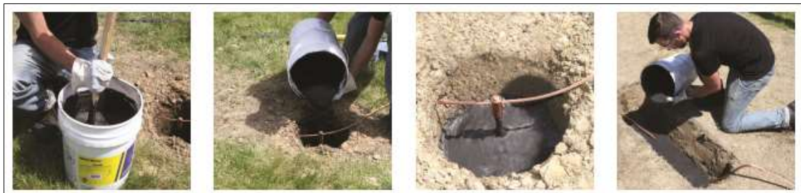
Figura G 15: Instalación de gel químico para puesta a tierra
