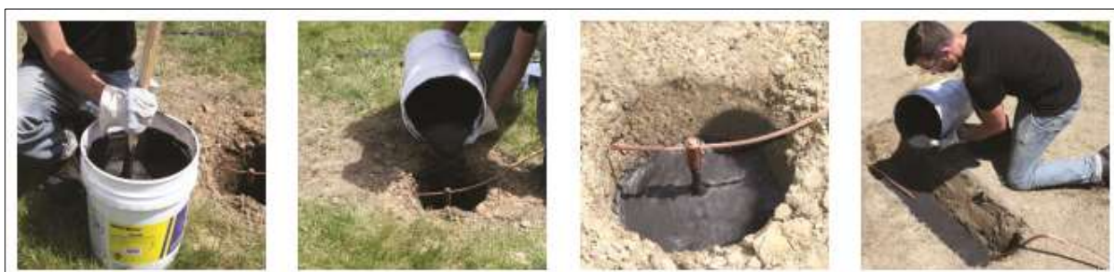
Figura 18: Instalación de gel químico para puesta a tierra
