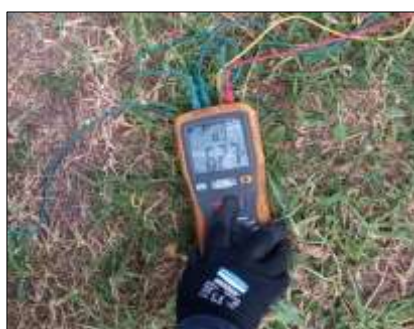
Figura 49: Resistencia de varilla instalada caso estudio 2
