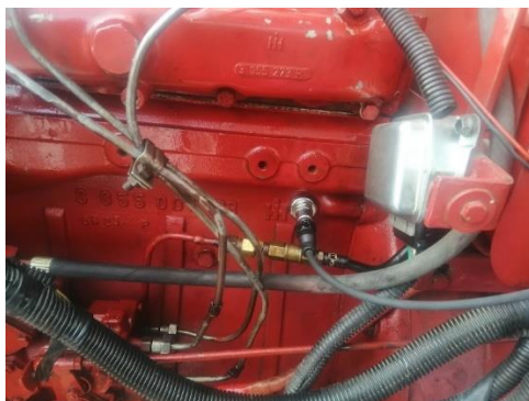
Anexo 1. Sensor de vibraciones correctamente colocado en el bloque motor.
