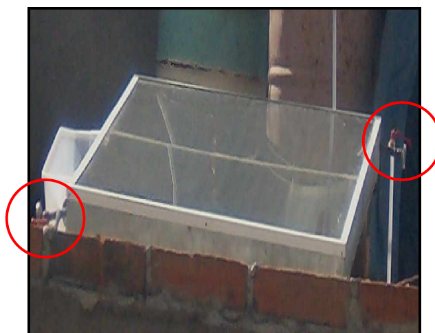
Fotografía N° 3.23. Llaves de control
