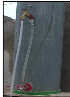
Fotografía N° 3.5. Salidas del agua
