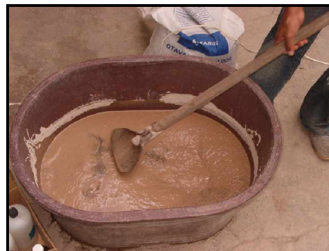
Fotografía N° 3.8. Lavado con peróxido de hidrógeno
