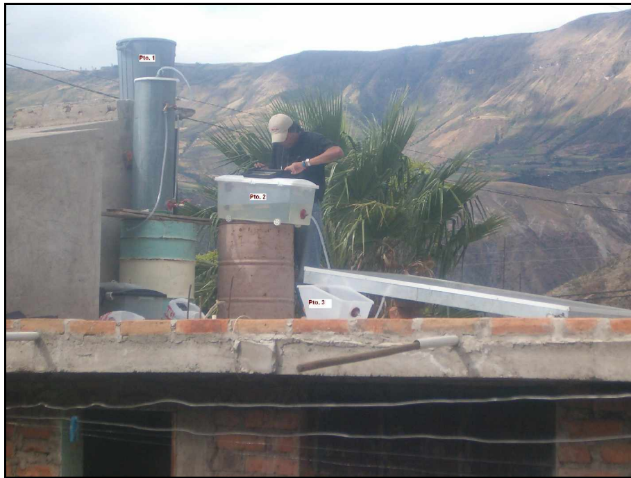
Fotografía N° 5 Sistema prototipo montado en la vivienda
