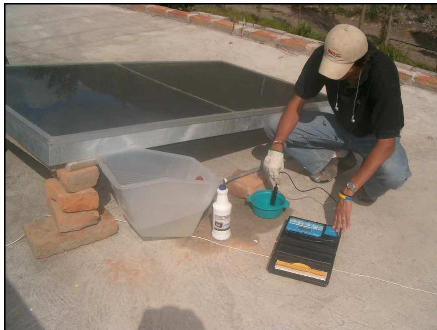
Fotografía N° 2 Toma de datos in situ
