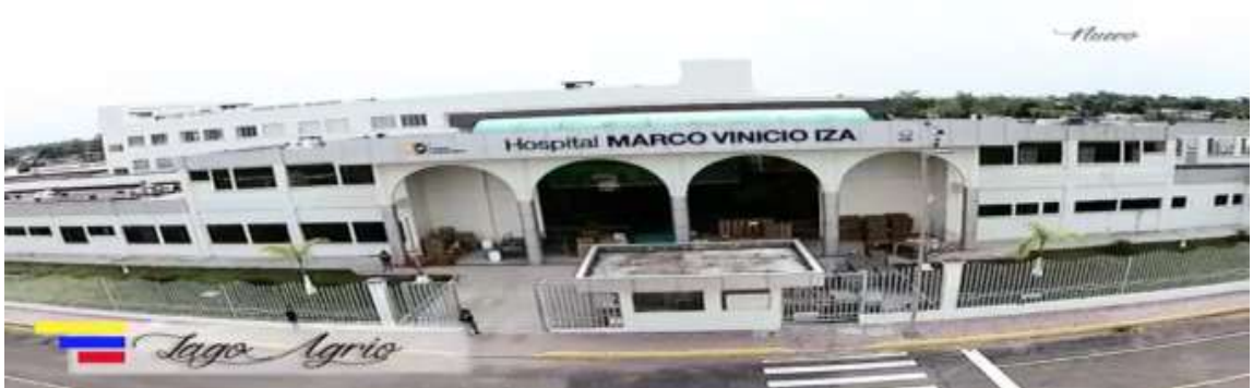
Imagen.1: 1 Hospital General Marco Vinicio Iza ( Nuevo )
