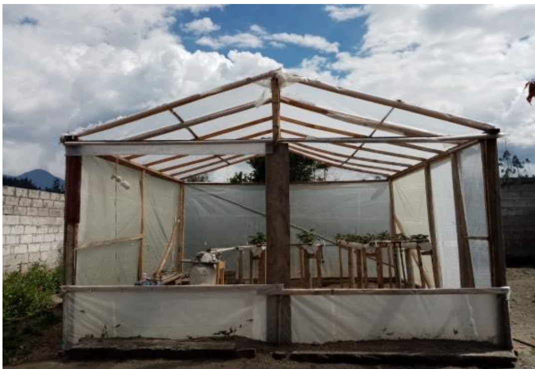
Figura 50. Invernadero tipo capilla terminado Fuente: Elaborada por el autor
