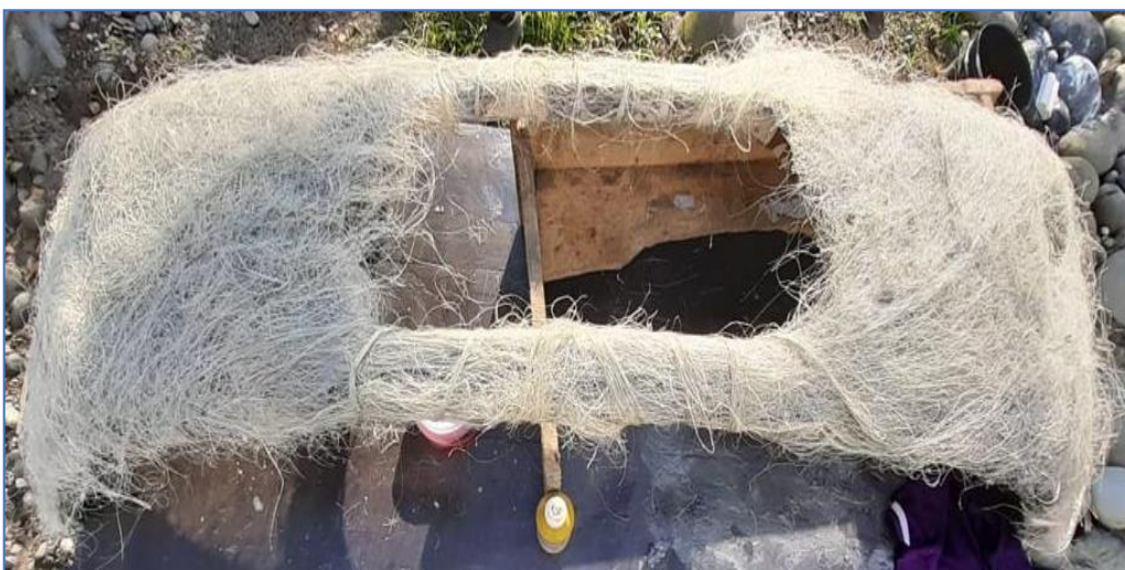
Figura 3.21 Tercera capa de refuerzo
