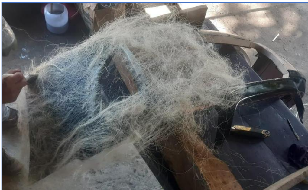
Figura 3.20 Primera capa de refuerzo
