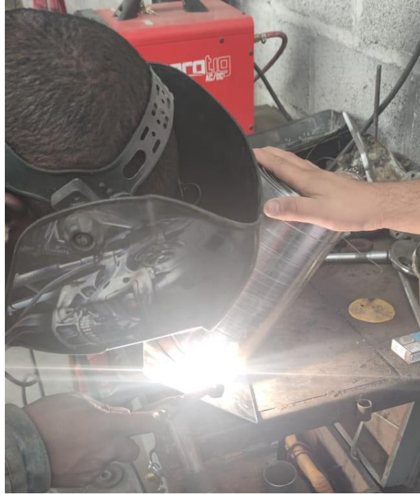
Figura 3.48 Unión mediante soldadura.
