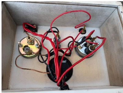
Figura 2.43 Instalación de manómetros
