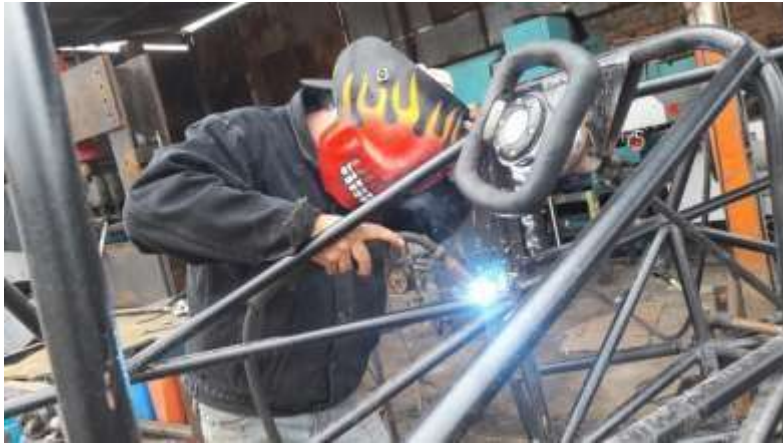
Figura 46. Soldadura bases de suspensión
