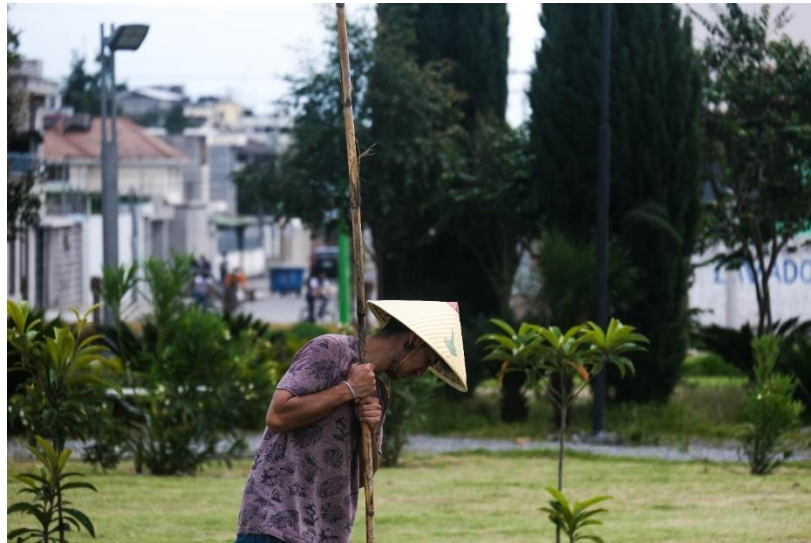
Figura 54 Entierro del primer junco que serviría de eje para el resto de la estructura. Fuente: Archivo del autor.
