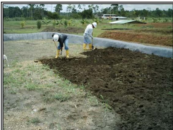
Foto 10. Tratamiento de suelos contaminados con petróleo, utilizando técnicas de landfarming
