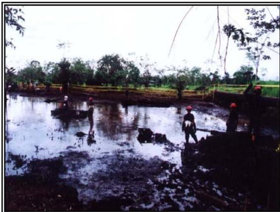
Foto 9. Derrame de crudo del SOTE y trabajos de recolección de crudo.
