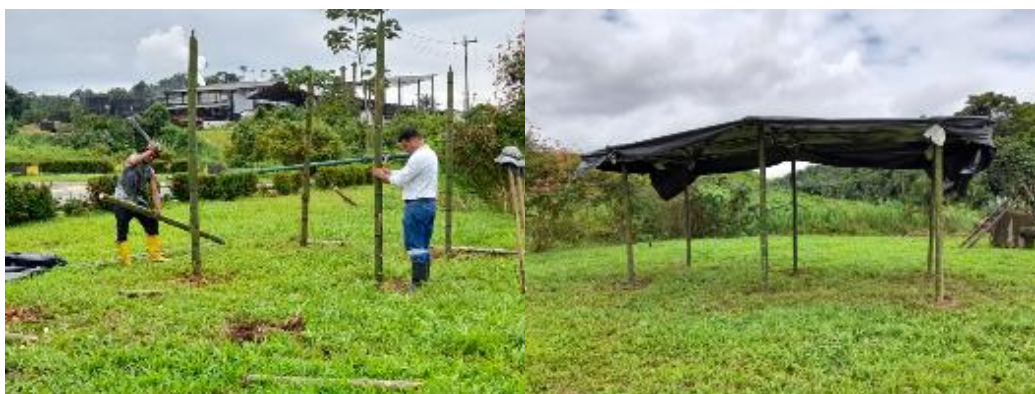
Figura 4.1. Adecuación del área para el ensayo de preparación de compost.
