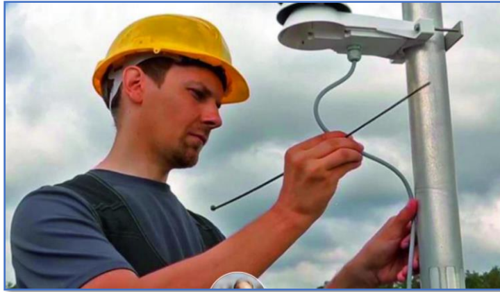
Figura 4. Mantenimiento al sensor de viento
