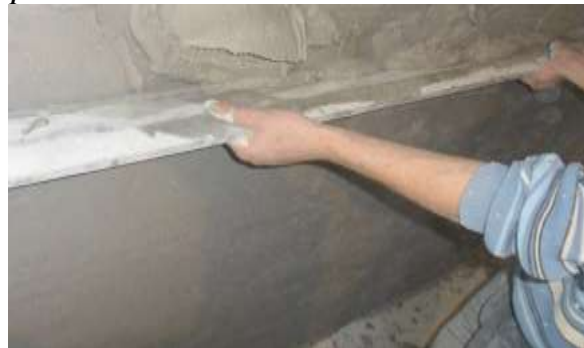
Figura 10. Codaleo de la pared retirando exceso de mortero
