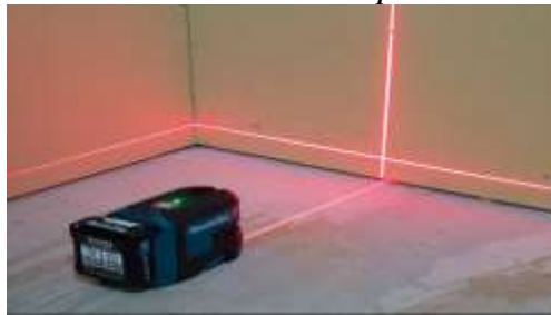
Figura 14. Nivel laser para pedestales en la instalación del piso técnico
