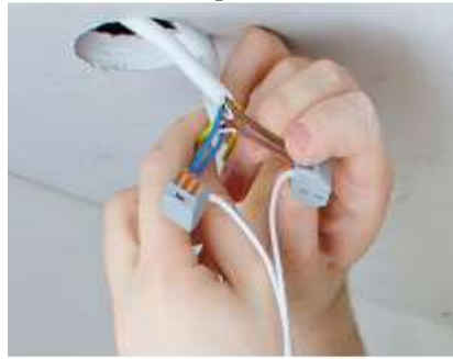
Figura 2. Extraer la luminaria anterior de su emplazamiento
