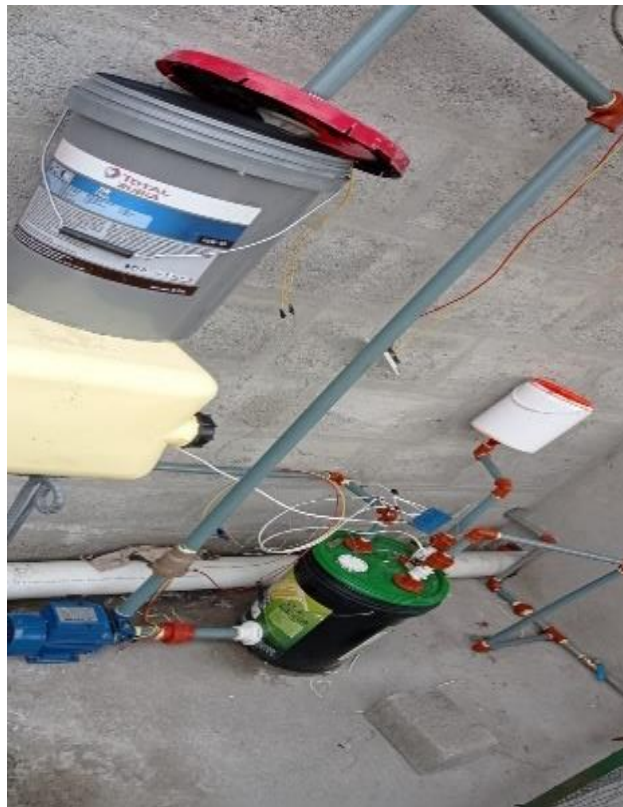
Figura 4.24 Instalación del sistema de taques.
