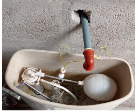
Figura 4.23 Instalación del dispositivo en el inodoro
