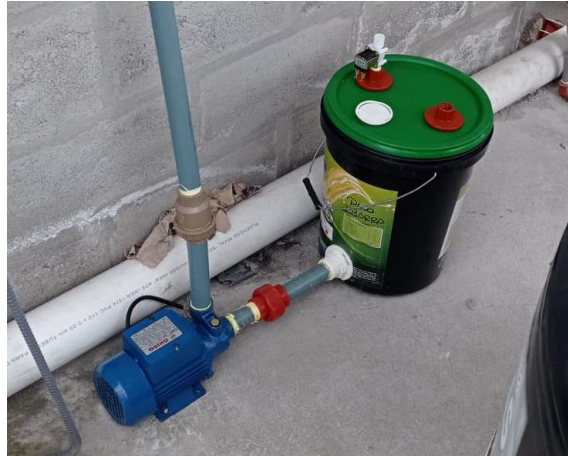
Figura 4.20 Construcción del sistema de almacenamiento
