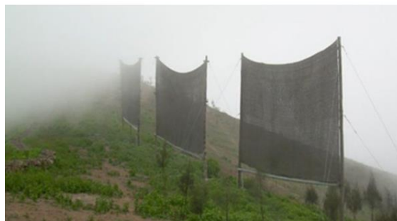
Figura 2.3 Métodos de recolección de agua por captación de nieblas [9]
