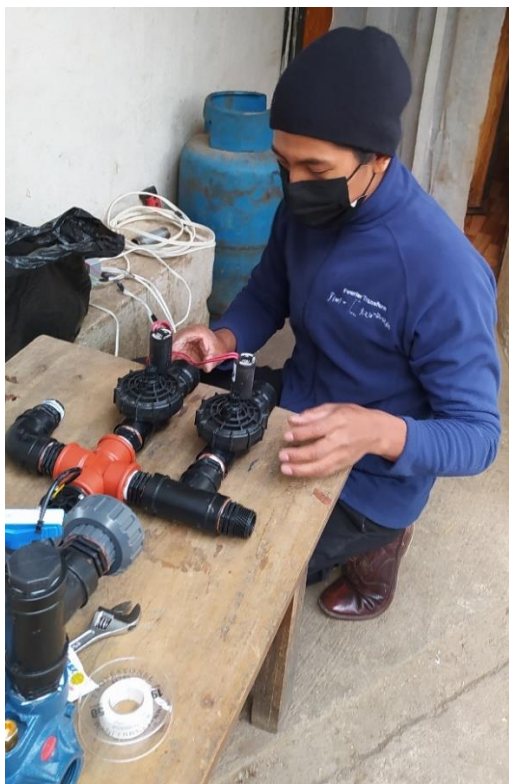
Figura 4. 4 Desmontaje de válvulas manuales
