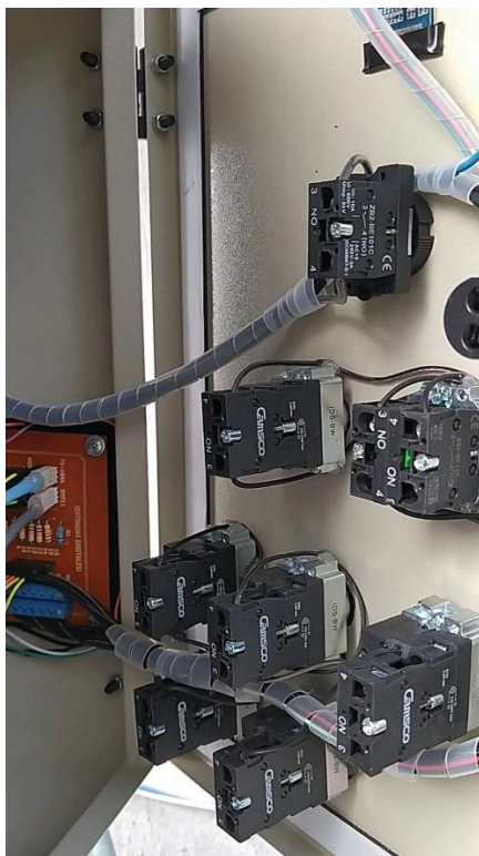
Figura 4. 10 Cableado de botones y selectores
