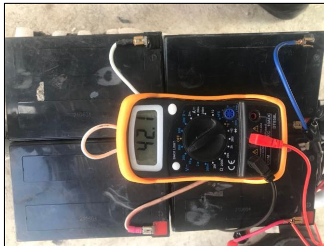
Figura 48: Medición de la conexión en serie de las baterías
