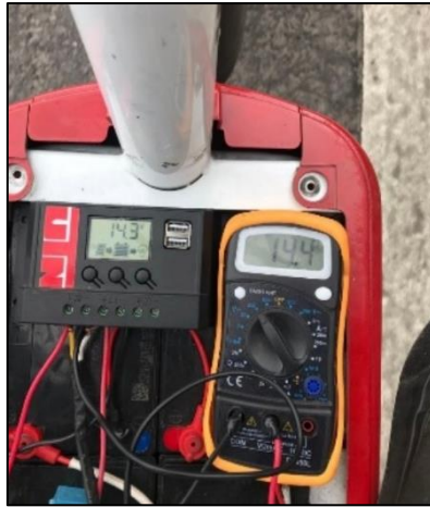
Figura 56: Medición de señales eléctricas de carga
