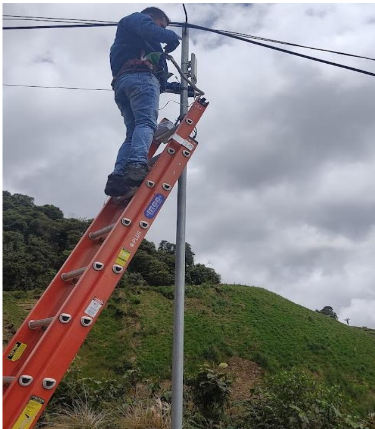
Instalación de nodo coordinador
