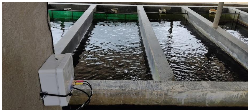
Instalación de Nodos Remoto B
