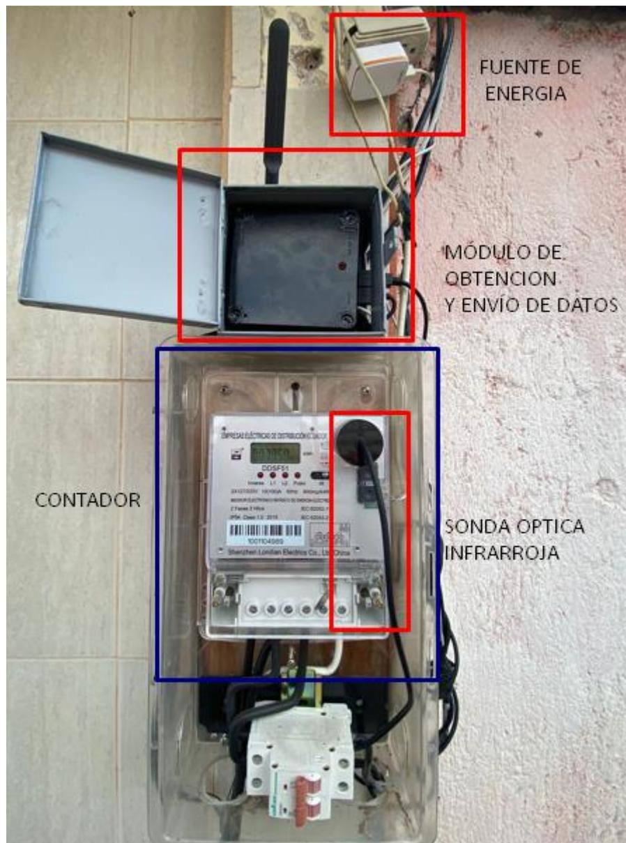
Figura 71. Instalación del dispositivo final con sus componentes
