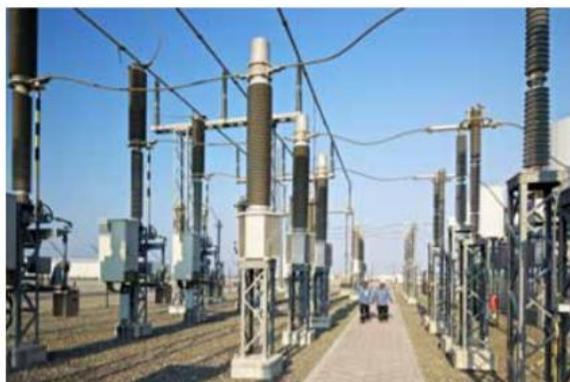
Figura 10. Transformadores de corriente en Subestación Omán
