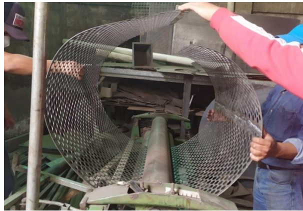
Figura 55: Rolado de lámina perforada
