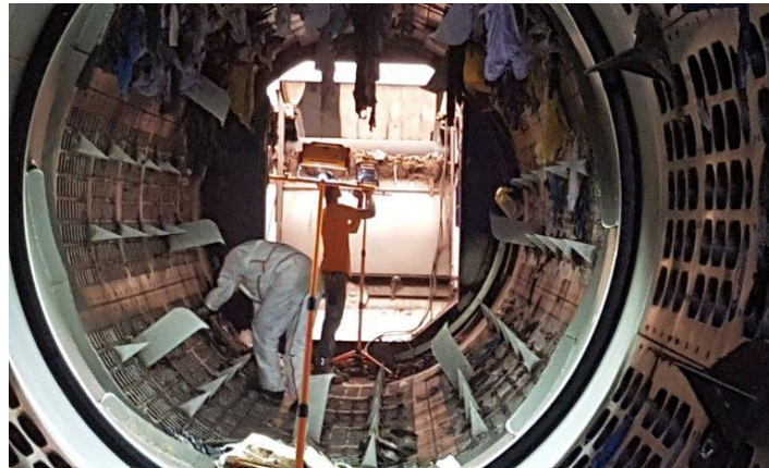
Figura 26: Eliminación de paletas del sistema [30]
