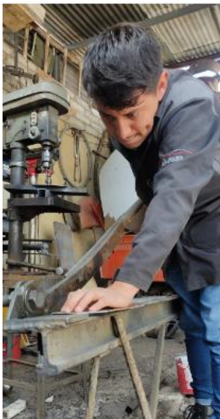
FIGURA A1.5 Corte del cuerpo del silenciador
