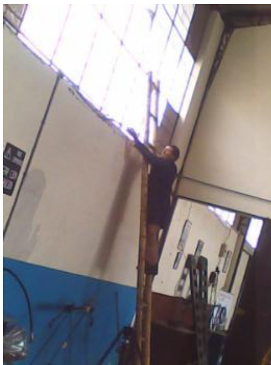
Figura 47. Adecuación de cableado eléctrico. (Rivera Pinto & Valdez Perugachi, 2012).
