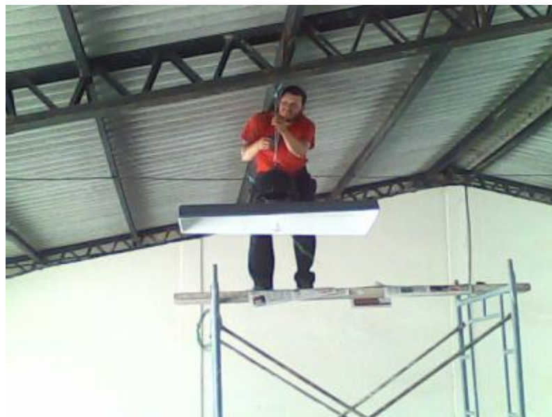
Figura 39. Alquiler de andamios e instalación de luminarias principales. (Rivera Pinto & Valdez Perugachi, 2012).
