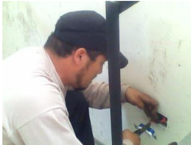
Figura 46. Instalación de tomacorrientes. (Rivera Pinto & Valdez Perugachi, 2012).
