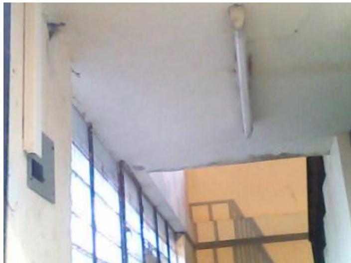
Figura 45. Instalación de luminarias en pasillos. (Rivera Pinto & Valdez Perugachi, 2012).
