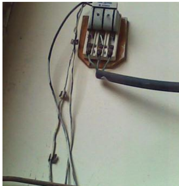
Figura 29. Palanca de control tanto de 110 como de 220, obsoleta en sus funciones. (Rivera Pinto & Valdez Perugachi, 2012).
