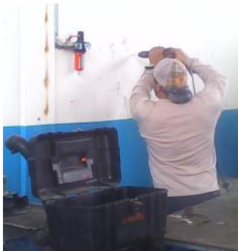
Figura 48. Instalación de accesorios del aire comprimido. (Rivera Pinto & Valdez Perugachi, 2012).
