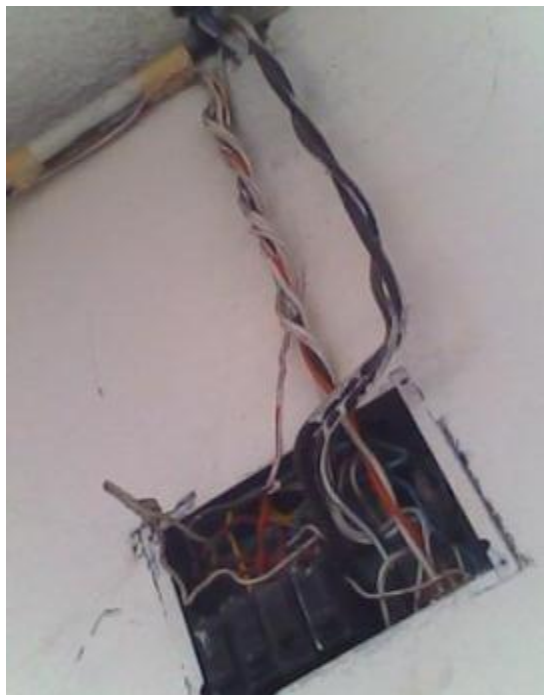
Figura 27. Caja térmica con un número indeterminado de cables sin que se sepa a ciencia cierta su utilidad. (Rivera Pinto & Valdez Perugachi, 2012)
