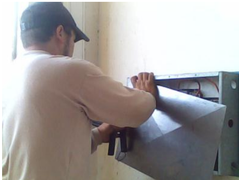
Figura 41. Aseguramiento de la caja principal de distribución. (Rivera Pinto & Valdez Perugachi, 2012).
