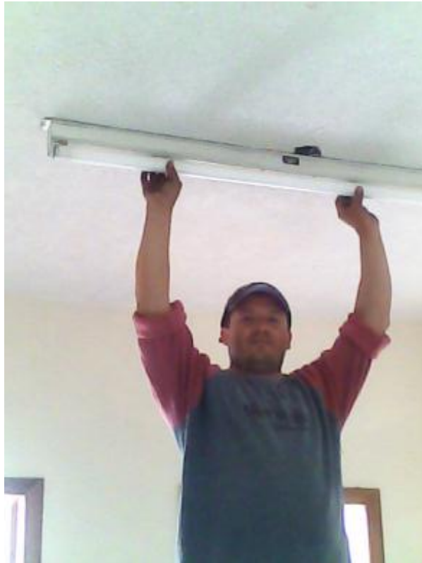
Figura 44. Instalación de lámparas secundarias en oficinas, bodegas, aulas. (Rivera Pinto & Valdez Perugachi, 2012).
