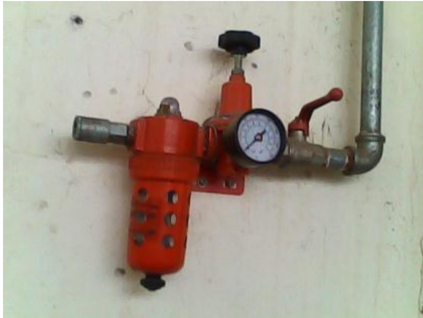
Figura 26. Filtros de aire: el único existente en el taller. (Rivera Pinto & Valdez Perugachi, 2012)
