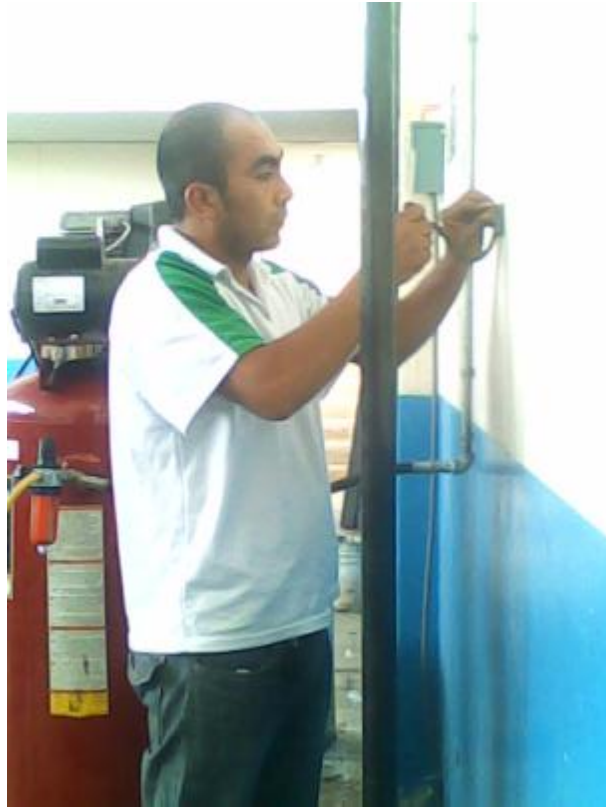
Figura 49. Instalación de soportes para manguera de presión. (Rivera Pinto & Valdez Perugachi, 2012).
