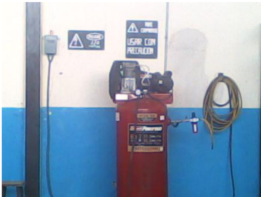
Figura 52. Nueva adecuación eléctrica y neumática en el compresor con su respectivo filtro, acoples rápidos y manguera de presión con su respectivo soporte. (Rivera Pinto & Valdez Perugachi, 2012).
