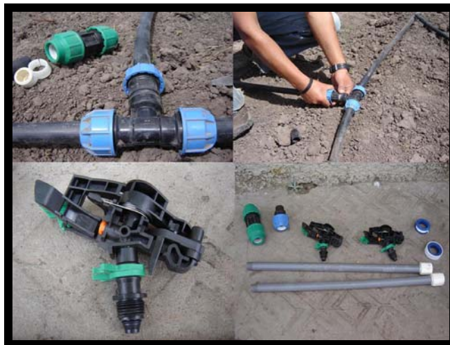
Foto 4.I.3. Instalación accesorios Elaboración: Autores
