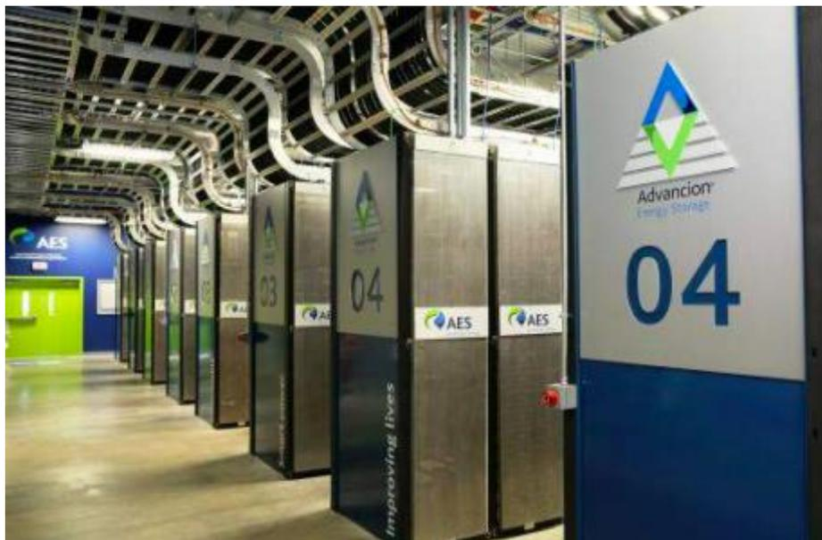
Figura 3.4 Sistema de almacenamiento de baterías (BESA)
