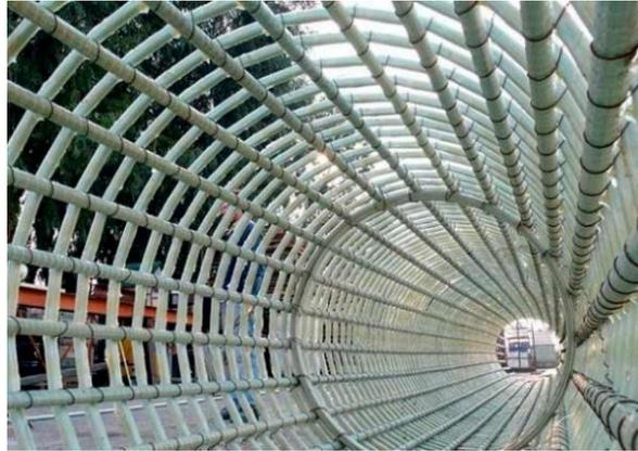
**Figura 17:** Estructura de construcción con fibra de vidrio
