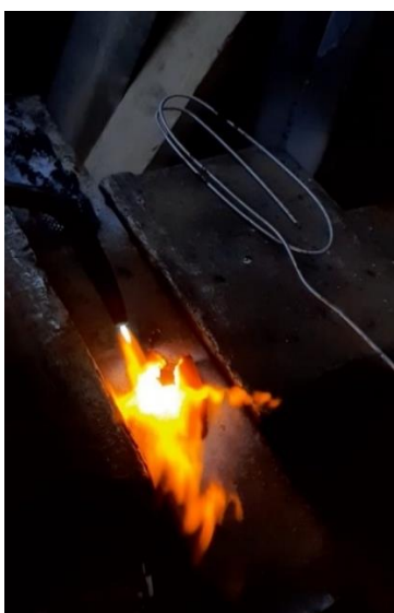
Figura 3.33 Soldadura oxiacetilénica en electrodos. Fuente: Autores
