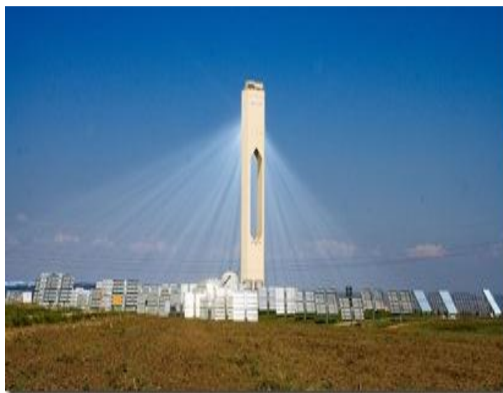
(S.A., Paneles Fotovoltaicos, 2012)Fig. 3
