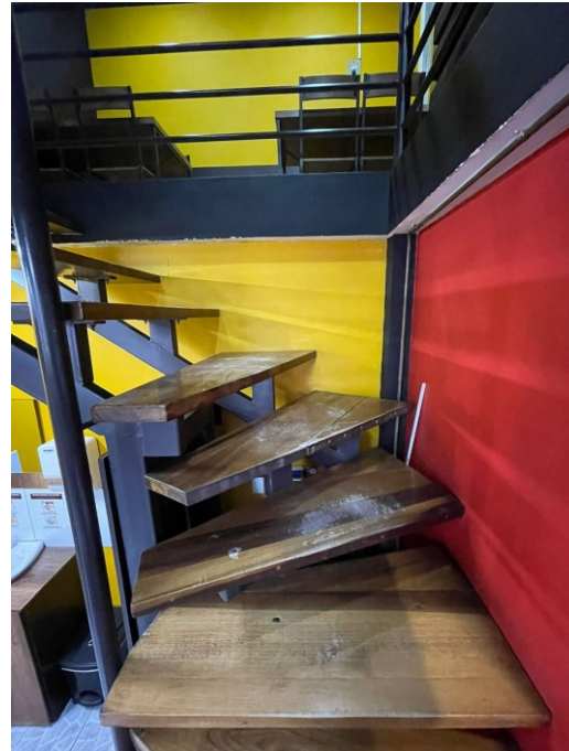
ACCESO INTERMEDIO AL SEGUNDO NIVEL
