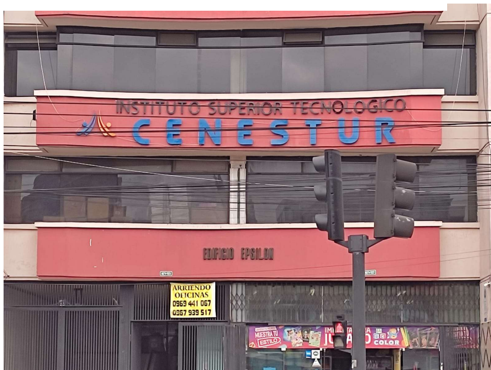
Ilustración 2 Fachada del edificio sede de CENESTUR
