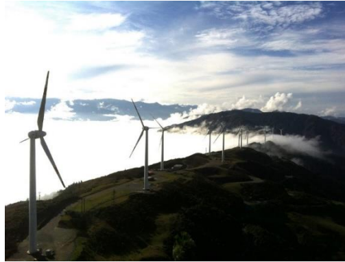
Fig. 1.20. Central de generación Eólica Villonaco.
