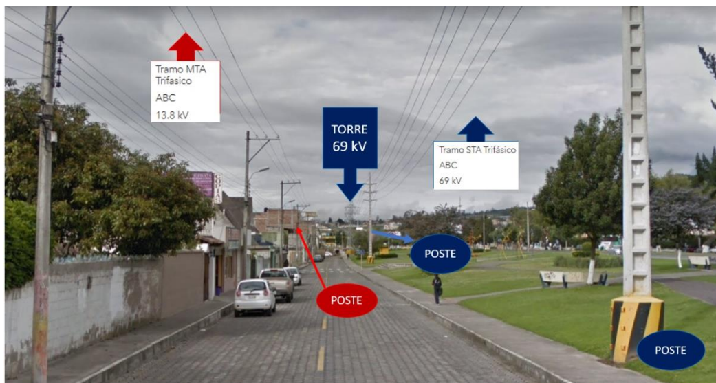
Fig. 2.5. Red eléctrica existente.
