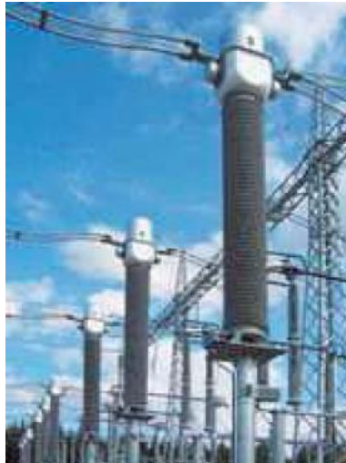
Ilustración 1.15. Transformador de corriente.
