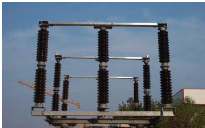
Ilustración 1.12. Seccionador de rotación central.
