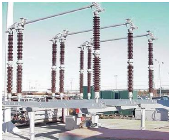
Ilustración 1.13. Seccionador de apertura vertical.
