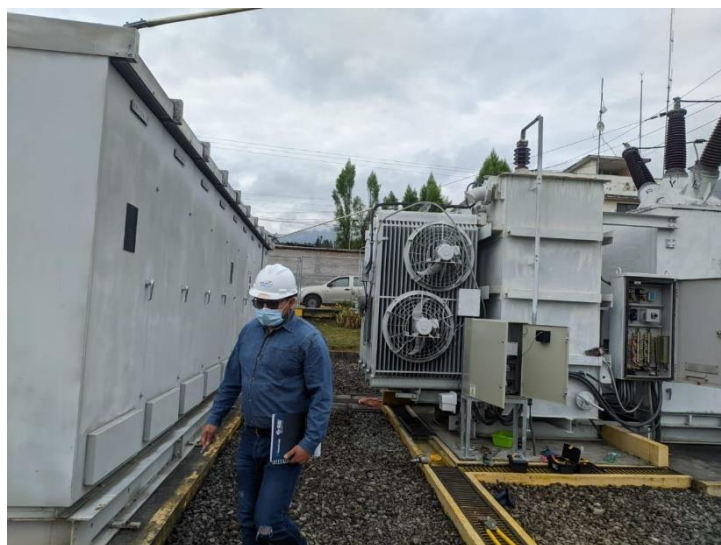
Ilustración 2.18. Levantamiento subestación El Retorno.
